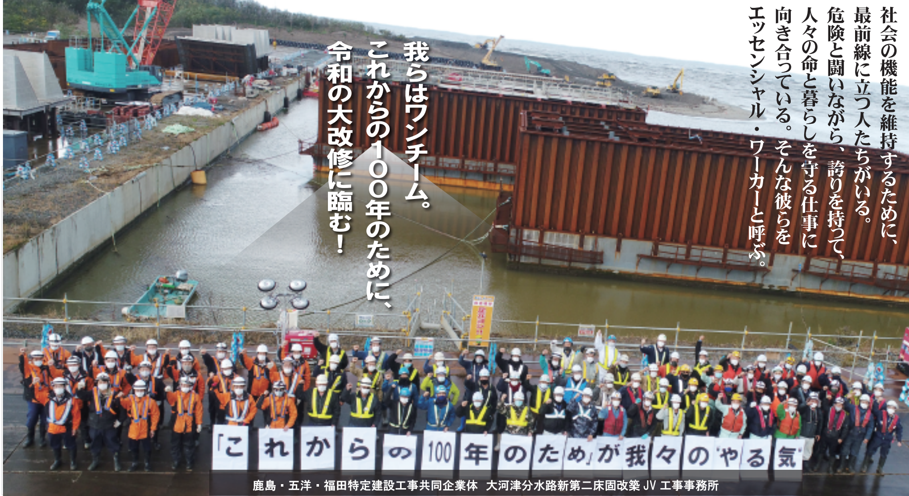
2019.10.12-13/ 大型台風19号の影響で分水路の鉄道橋まで水位が上がった。第二床固付近も、洪水が巻き上げる霧で、周囲は泥臭かった。工事現場は洪水がくれば、工事を止め、資材を川から運び出さなければならない。まさに、お天道様と相談しながらの、命がけの工事である。
