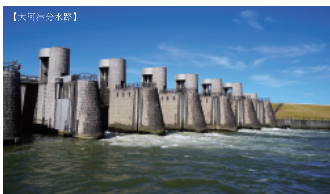
■協力：国土交通省 北陸地方整備局 信濃川河川事務所 鹿島・五洋・福田特定建設工事共同企業体 大河津分水路新第二床固改築 JV 工事事務所 ■企画編集：渡辺千雅
